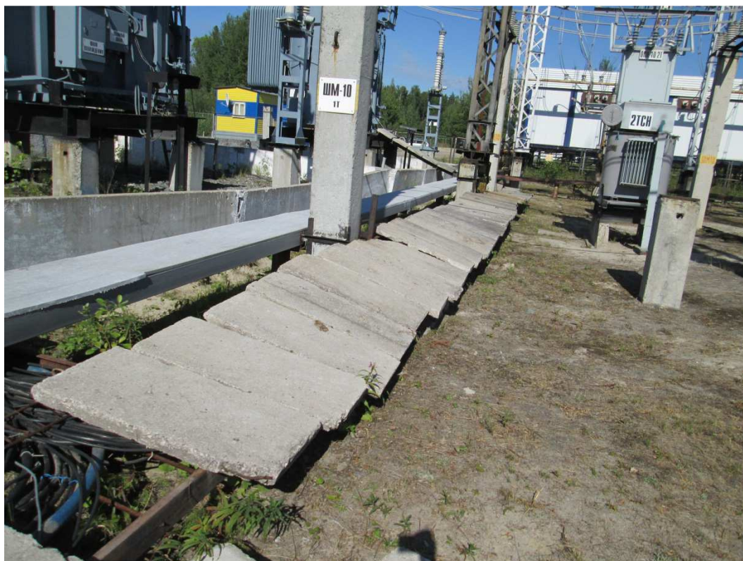
Рисунок А.4 - Общий вид кабельных каналов на ПС 110/10 кВ Нулевая КРЭС
